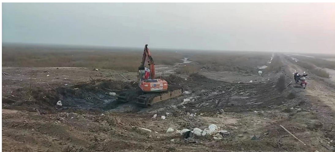
项目施工现场
