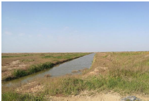
射阳 1 号水库修复前
