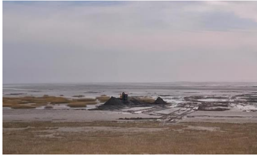
挖机正在清理条子泥北侧的互花米草
